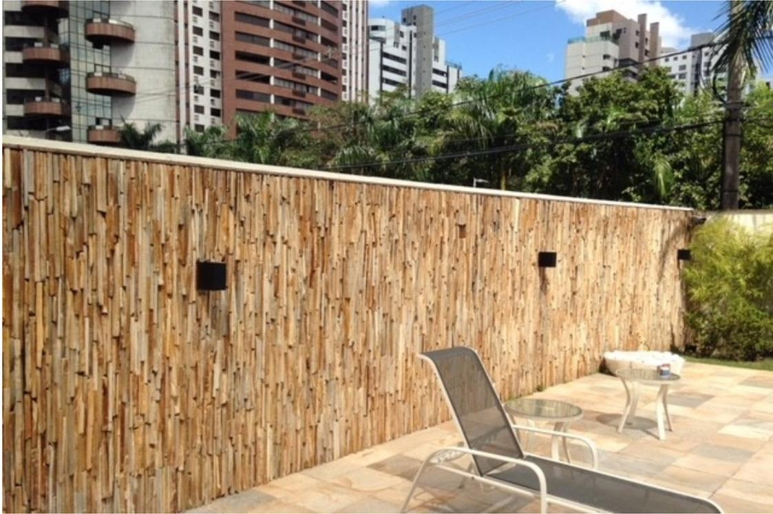
**Figura 10 - Aplicação de Pedra São Thomé, filetada, aplicada na vertical.**
